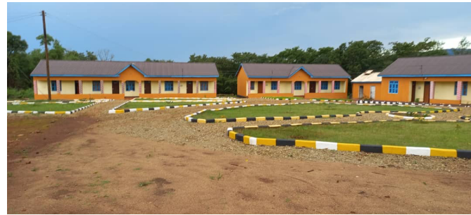
Der Bau des Bishop Maluma Training Centers ist fertiggestellt.
