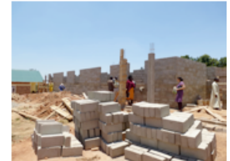
Block C im Bau
